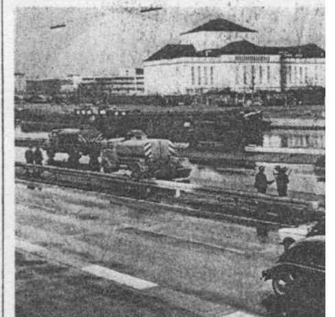
Vom Hochwasserschlamm gereinigt und seit gestern mittag freigegeben: die Stadtautobahn. Unser Bild zeigt städtische bei den letzten Säuberungsarbeiten.
